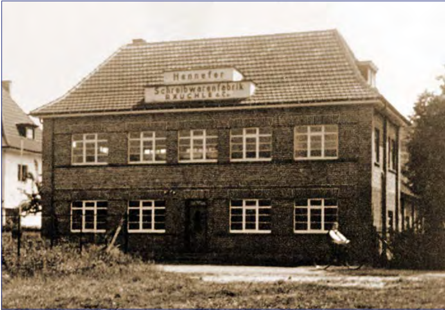
Neubau Bürogebäude in der Wehrstraße 12.
